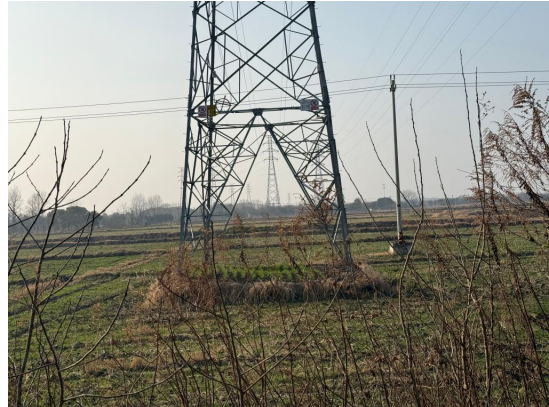
塔基生态恢复 (7#)
