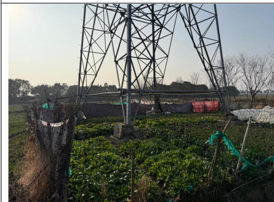
塔基生态恢复 (4#)
