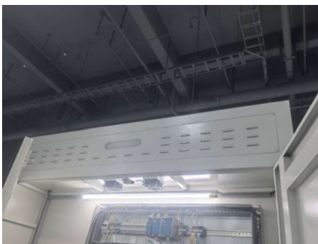
图 3-24 双立柱离线 CT 铅房通风管道铅防护罩
