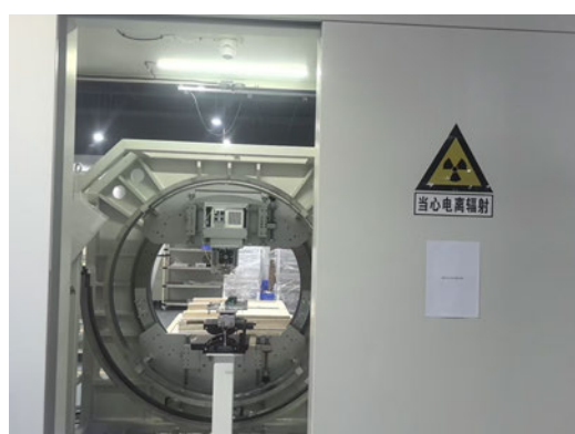
图 3-9 锂电环形 CT 铅房外警示标志
