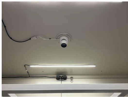
图 3-12 锂电环形 CT 铅房内部监控探头
