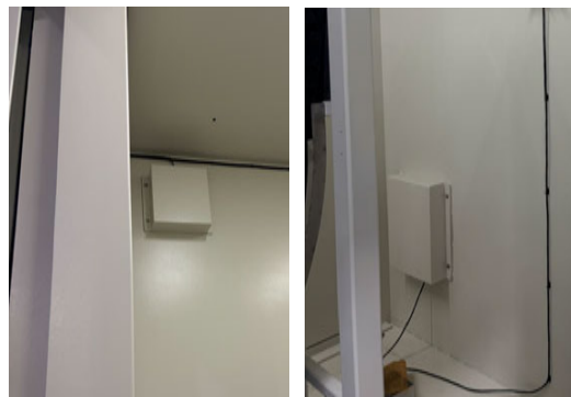
图 3-13 锂电环形 CT 铅房通风管道 铅防护罩
