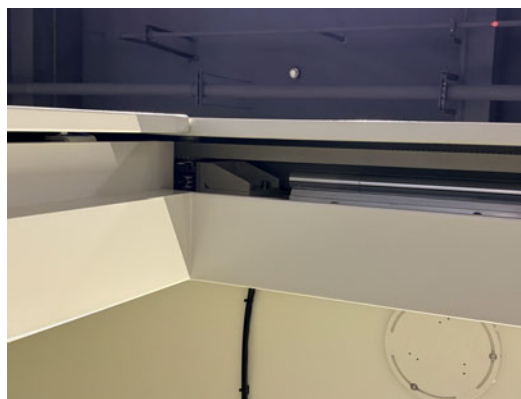
图 3-15 锂电环形 CT 铅房 门-机安全联锁装置
