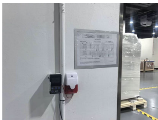
图 3-38 固定式场所辐射探测报警装置
