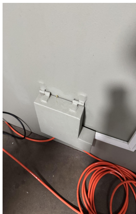
图 3-15 电缆管口
