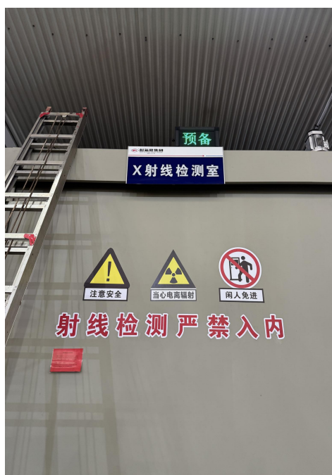
图 3-7 工件门（电离辐射标志、指示灯和声音提示装置、“照射”和“预备”信号意义的说明）
