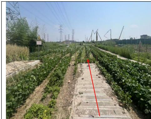
电缆沿线现状
