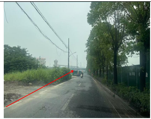
电缆沿线现状
